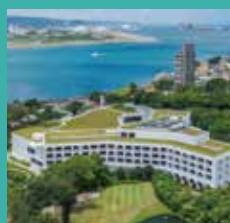
屋頂覆土綠化
